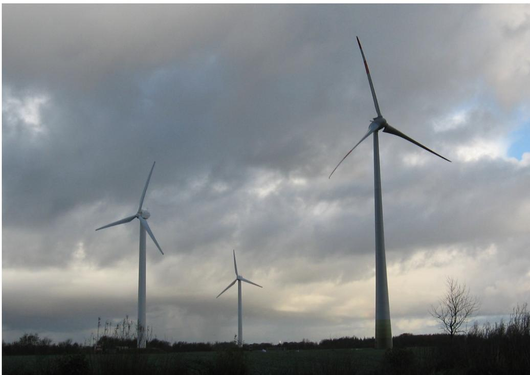
**Abbildung 16** Direkter Vergleich: Die alten Tacke-Anlagen (links) neben einer neuen Enercon E-82
