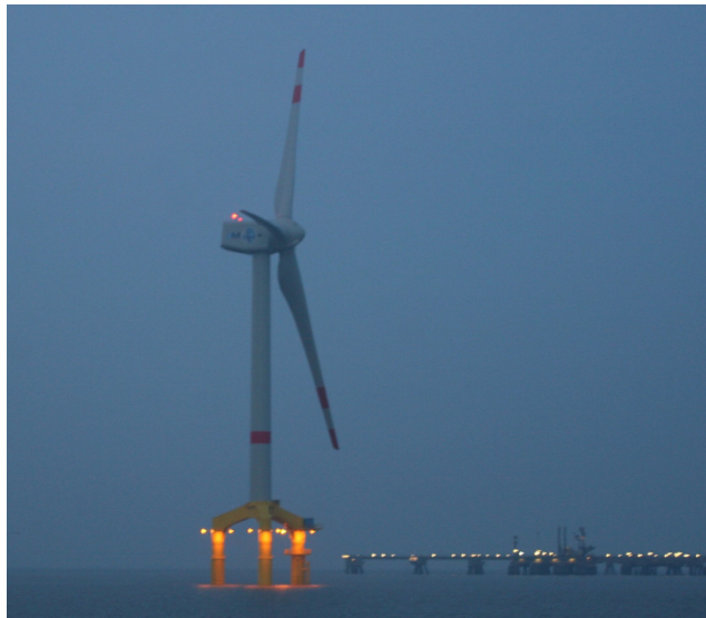
Abb. 26: Prototyp einer 5-MW-Offshore- Windenergieanlage der Firma Bard Engineering GmbH (Emden) nahe Hooksiel, Niedersachsen, in der Abenddämmerung. An der Gondel rote Blinkbefeuerung zur Gewährleistung der Sicherheit im Flugverkehr, im Fußbereich dauerhafte Anstrahlung von Flächen sowie Hindernisbefeuerung zur Gewährleistung der Sicherheit im Seeverkehr. Im Offshore-Bereich werden beleuchtete Windenergieanlagen auf weiten Flächen die einzigen Lichtquellen darstellen (Foto Tobias Dittmann).
