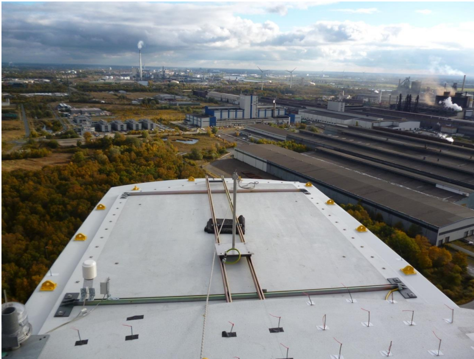
Abbildung 8: Schienensystem auf dem rückwärtigen Gondeldach der REpower 3.4M 104 in Bremen mit Temperatur-, Feuchte- und Druckmessung.
